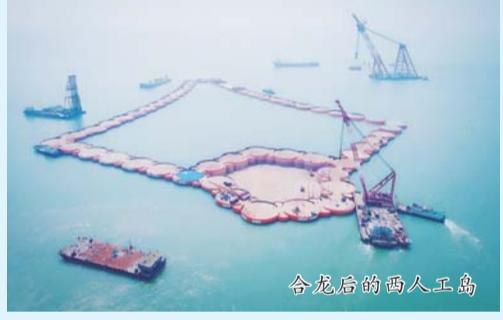
“我们把钢圆筒分为上下筒体拼接，每个筒体再通过钢板、片体像拼图那样拼起来会不会好一点？不过这需要‘拼图’各个环节的精度控制得十分到位才行。”一次研讨会上，徐波提出了一个广受认可的设想。很快，钢圆筒各环节的精度控制成为攻关重点。
