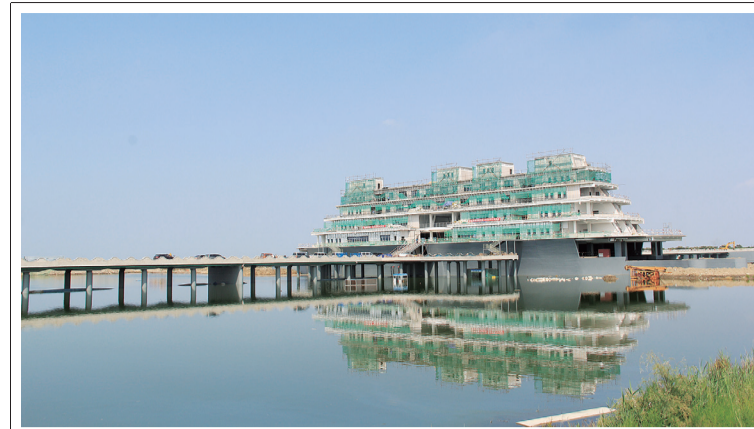
近日,四公司第四项目部承建的潍坊滨海经济开发区白浪河船闸橡胶坝工程主体顺利通过验收。该工程主体总重约1999吨,长约125米,宽约36米,高约25米。刘凯 摄影报道
