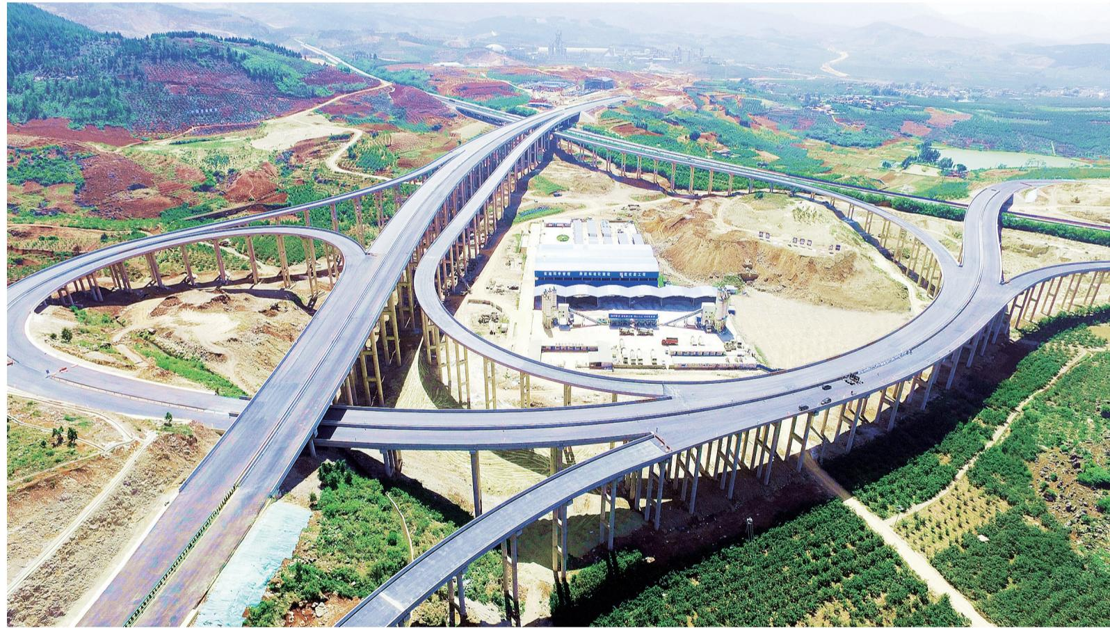
近日,一公司承建的蒙文砚高速蒙自互通已建成中间交工验收。蒙自互通主线全长1799米,为云南省最大的互通式立交桥,包括两座主线桥梁及5条匝道。
