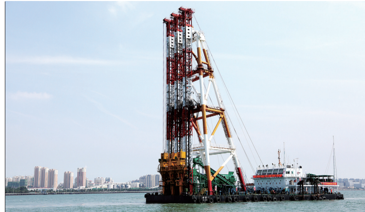
8月16日，“砂桩3号”船舶从二公司前海基地出发，奔赴深中通道参建西人工岛S02标挤密砂桩工程。“砂桩3号”曾用于港珠澳大桥西人工岛施工，目前已完成国产化改造，实现了国内自主掌控核心系统。 朱晓 顾新成 摄影报道
