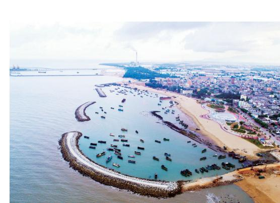
近日,由五公司海南项目部承建的乐东县莺歌海镇岸滩修复项目全部完工。工程修复岸线总长 1200 米,人工补沙千滩 6.28 公顷,滩面植被栽植施工 0.73 公顷,滨海公共亲水广场建设施工 2.53 公顷等。
