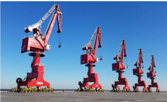
1月17日,一公司第十六项目部承建的天津港大港港区新建通用泊位码头和堆场施工通过交工验收。
