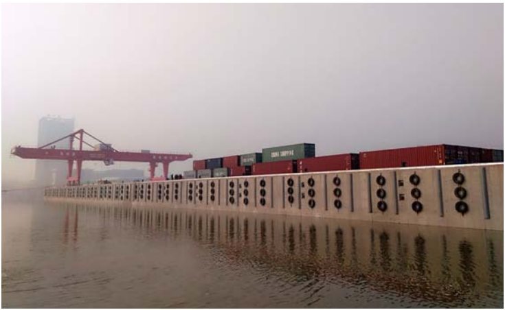
一月15日,二公司承建的徐州双楼港通用码头徐州至上海运河航线举行首航仪式。
