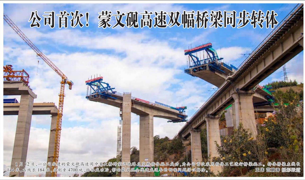
1月12日,一公司承建的蒙文砚高速周中寨大桥跨浔河倒桥立交桥转体施工成功,为公司首次采用转体工艺进行桥梁施工。转体桥墩在144米,右线长184米,分别重4700吨,转体成功后,影响蒙文砚全线建成通车的咽喉问题得以解除。
