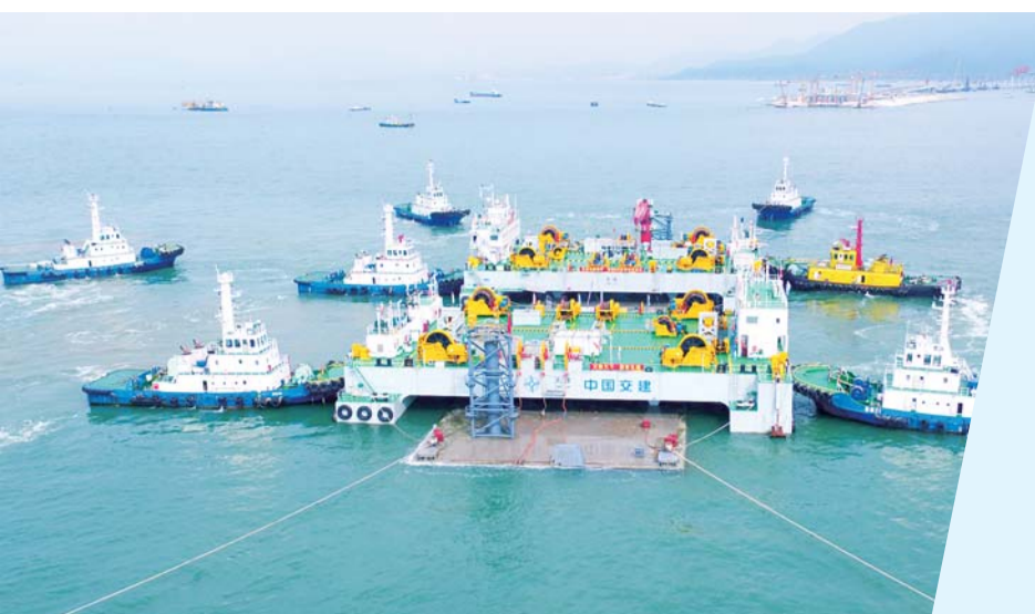
港珠澳大桥 E33 沉管成功安装 尹晓伟 摄
