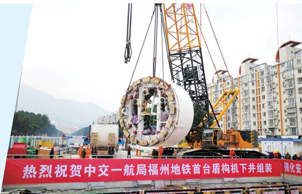
福州地铁2号线前屿站盾构机下井组装 李忠磊 摄
