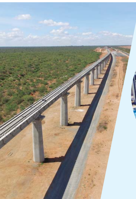
蒙内铁路察沃河大桥 王秉辰 摄
