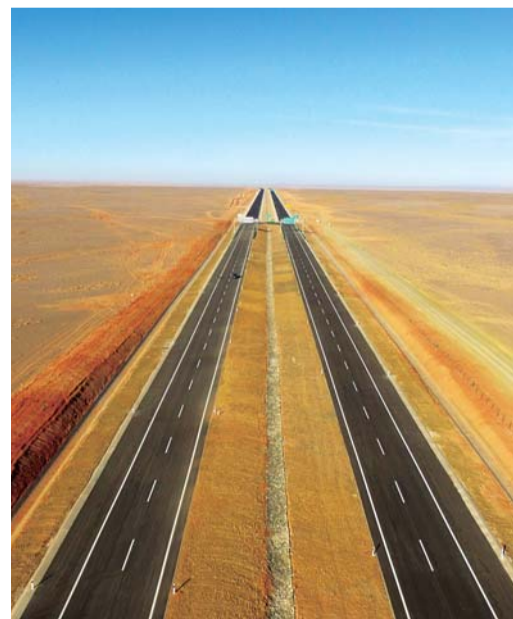
京新高速公路工程 翟超 摄
