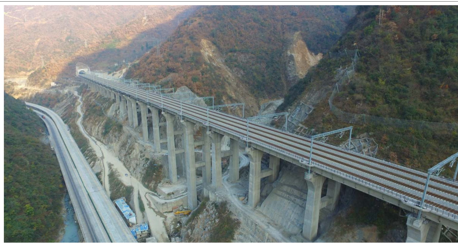
近日,一公司第八项目部承建的兰渝铁路枫相院车站特大桥已完成静态验收工作。该大桥全长1021.6米,共有墩台33个,最高墩柱高59米。刘锟 田红涛 摄影报道
