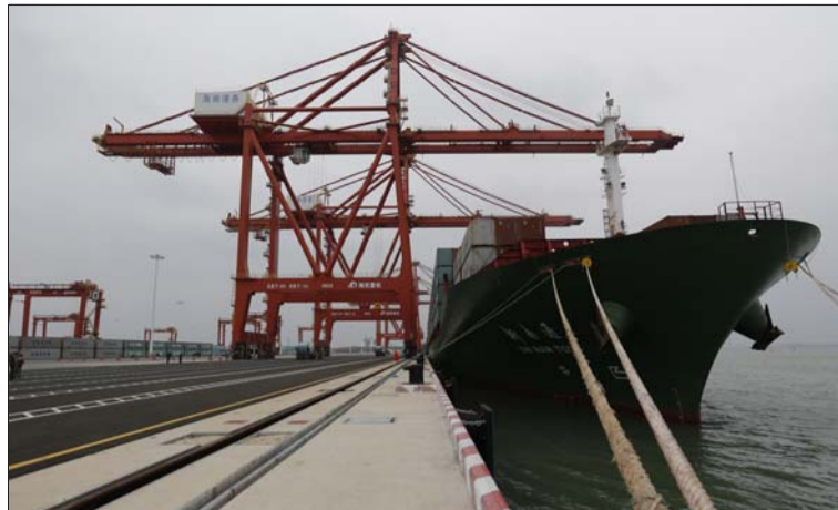
12月16日,海南国际港务洋浦港区举行开港仪式。二公司承建了一起起步工程3个5万吨级多用途码头泊位。田普江 摄影报道
