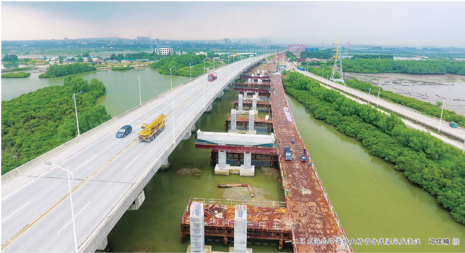
玉湛高速建设中的大桥桥墩外立面造型独特
