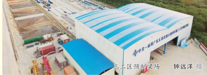
三工区预制梁场
