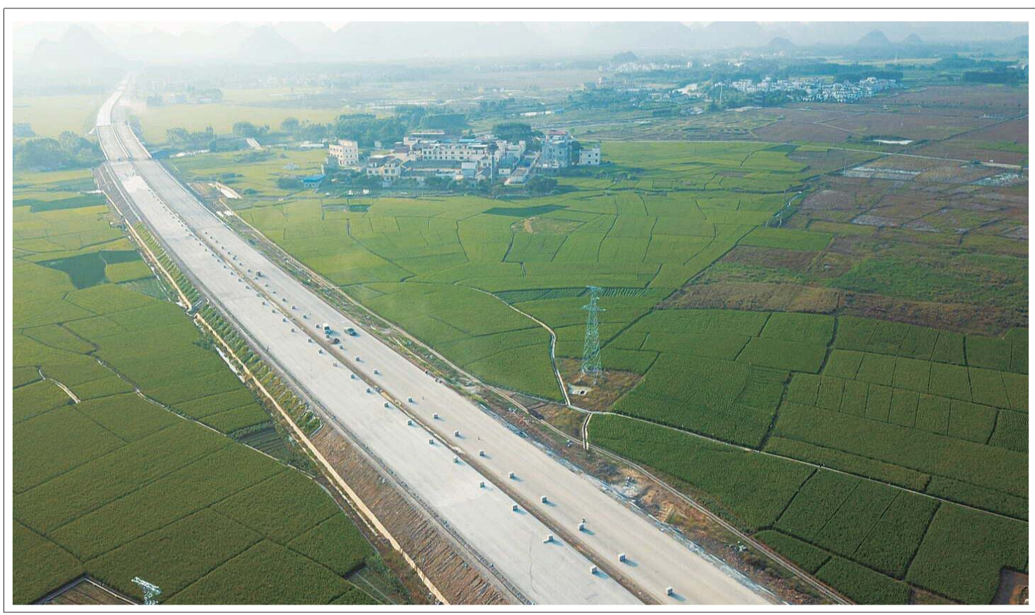
桥梁的桥面系施工任务。 一月四日广西贵港高速公路三分部顺利完成主线及匝道桥面系施工任务。 杜建军 李文文 摄影报道
