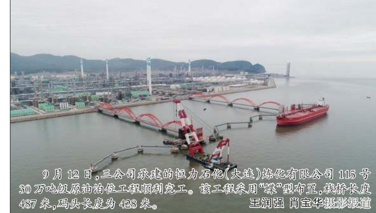
9月12日,三公司承建的恒力石化(大连)炼化有限公司 115 号 30 万吨级原油泊位工程顺利完工。该工程采用“蝶”型布置,栈桥长度 487 米,码头长度为 428 米。
