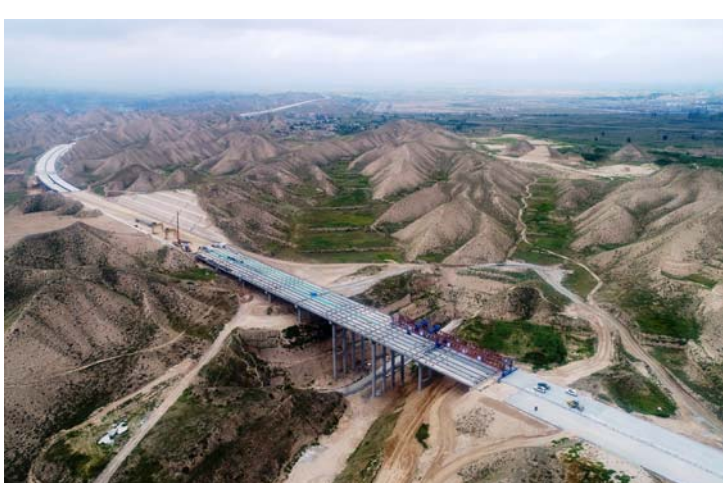
8月23日,五公司景中高速JZ6合同段总计22座桥梁板架设全部完成。 王健 王志鹏 摄影报道
