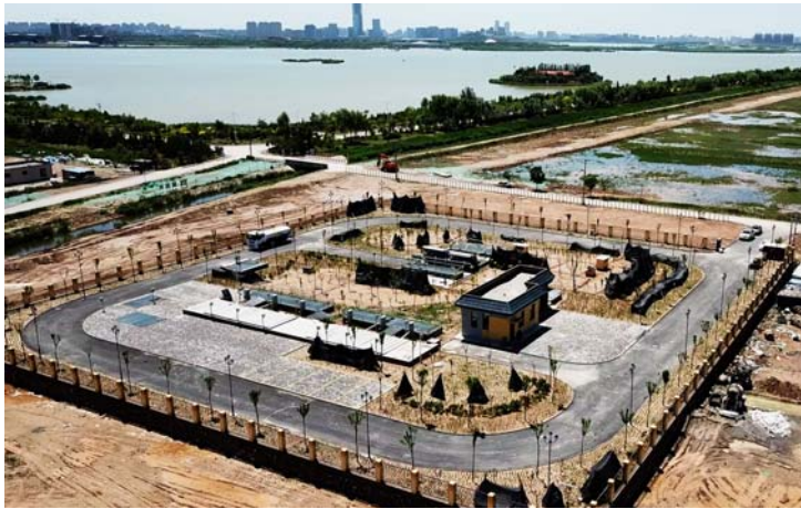
近日,三公司承建的广州市建成区水体清污分流工程EPC总承包项目(一标段)顺利通过竣工验收。 高明慧 摄影报道
