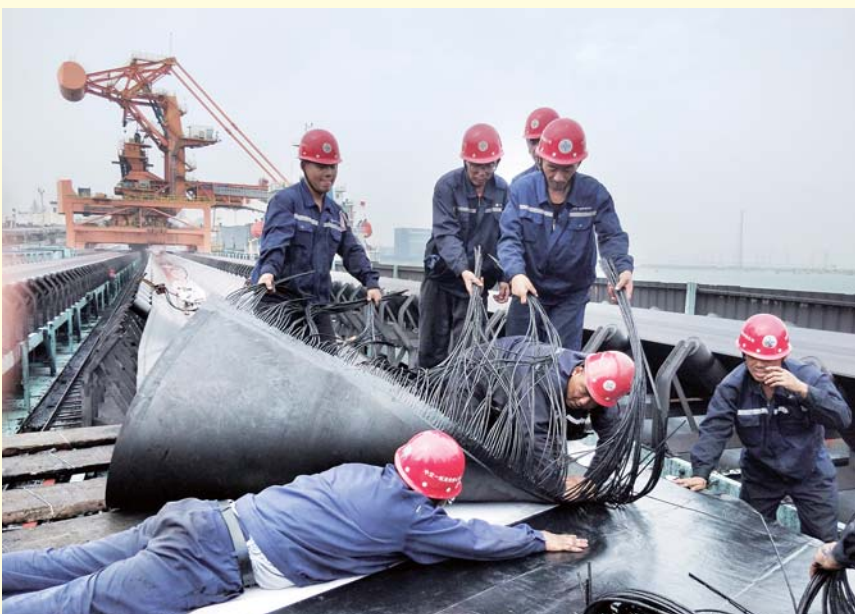
安装公司黄骅港运维项目开展故障排查抢修，在台风来临前确保港区内正常生产作业。赵路 摄影报道
