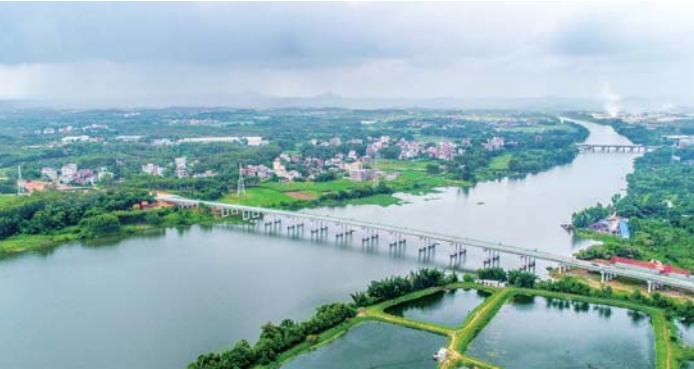
近日,广东玉湛高速九洲江大桥半幅贯通,为后续材料运输、箱梁架设提供便利。禹丁楠 摄影报道
