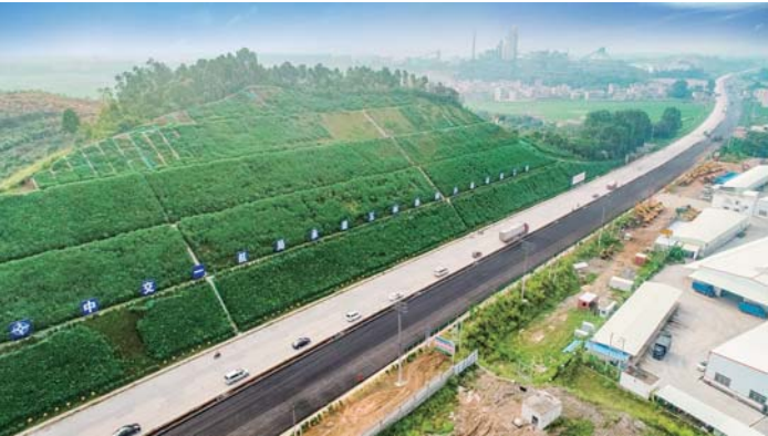
8月13日,三公司承建的玉林路网项目民主南路改扩建工程陆川段右幅沥青混凝土路面摊铺施工全部完工。张鑫 摄影报道
