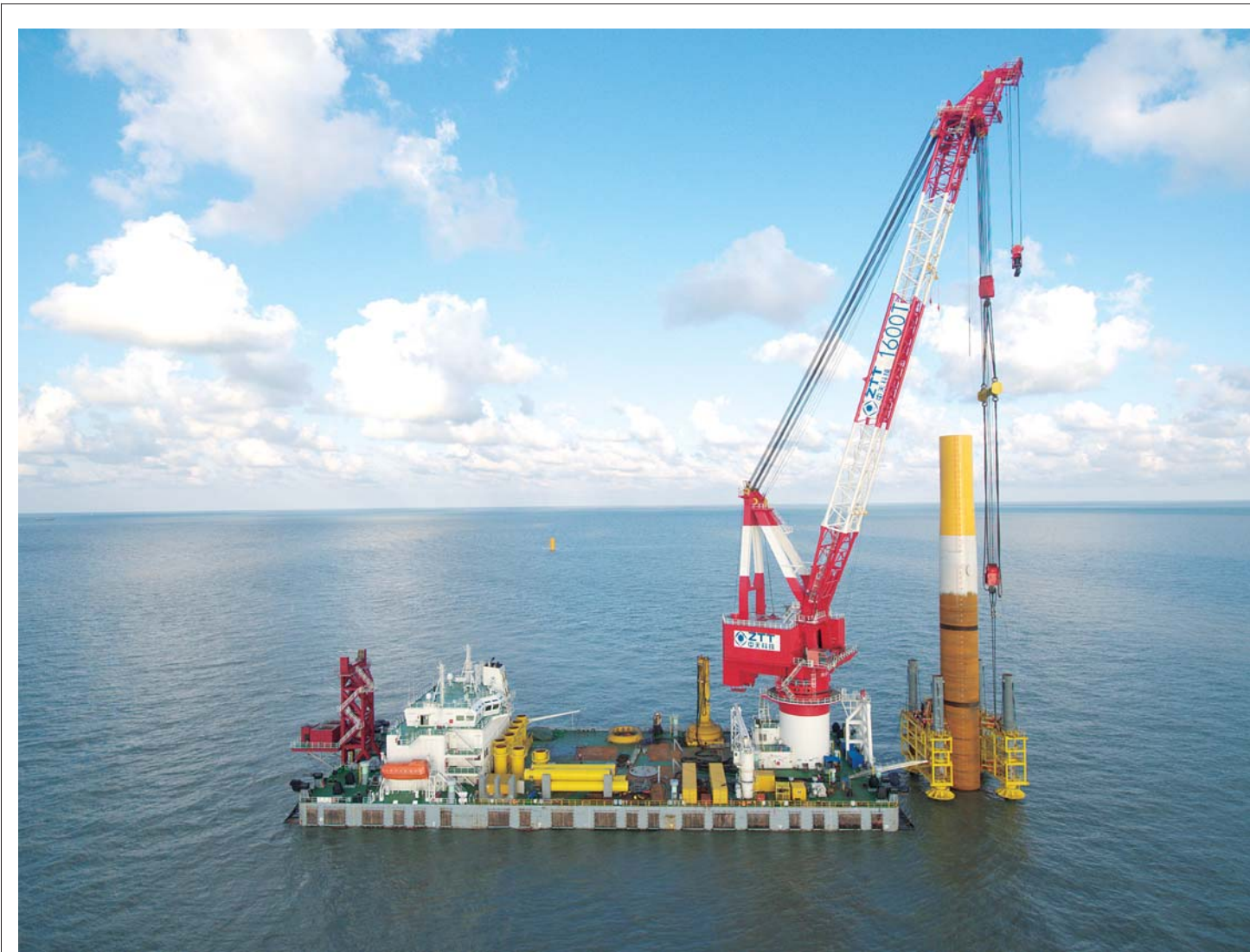
8月20日,总承包分公司和一公司联合施工的江苏大丰海上风电项目沉桩施工全部完成。苗晓炜 陈飞羽 摄影报道
