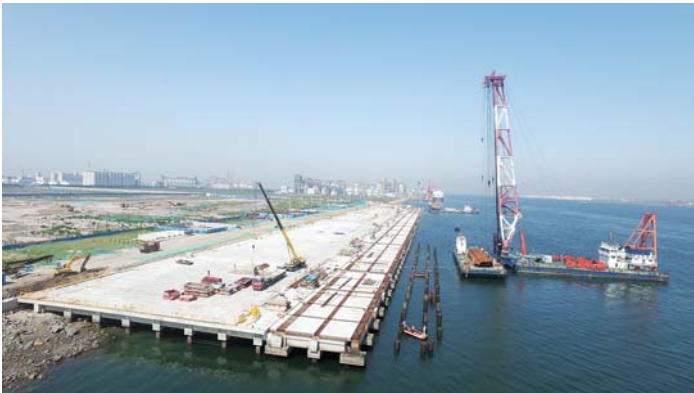
近日,一公司承建的天津港大沽口港区6、7号通用泊位工程码头施工项目后承台梁安装全部完成,钢桩沉桩超过70%。崔瑞松 摄影报道
