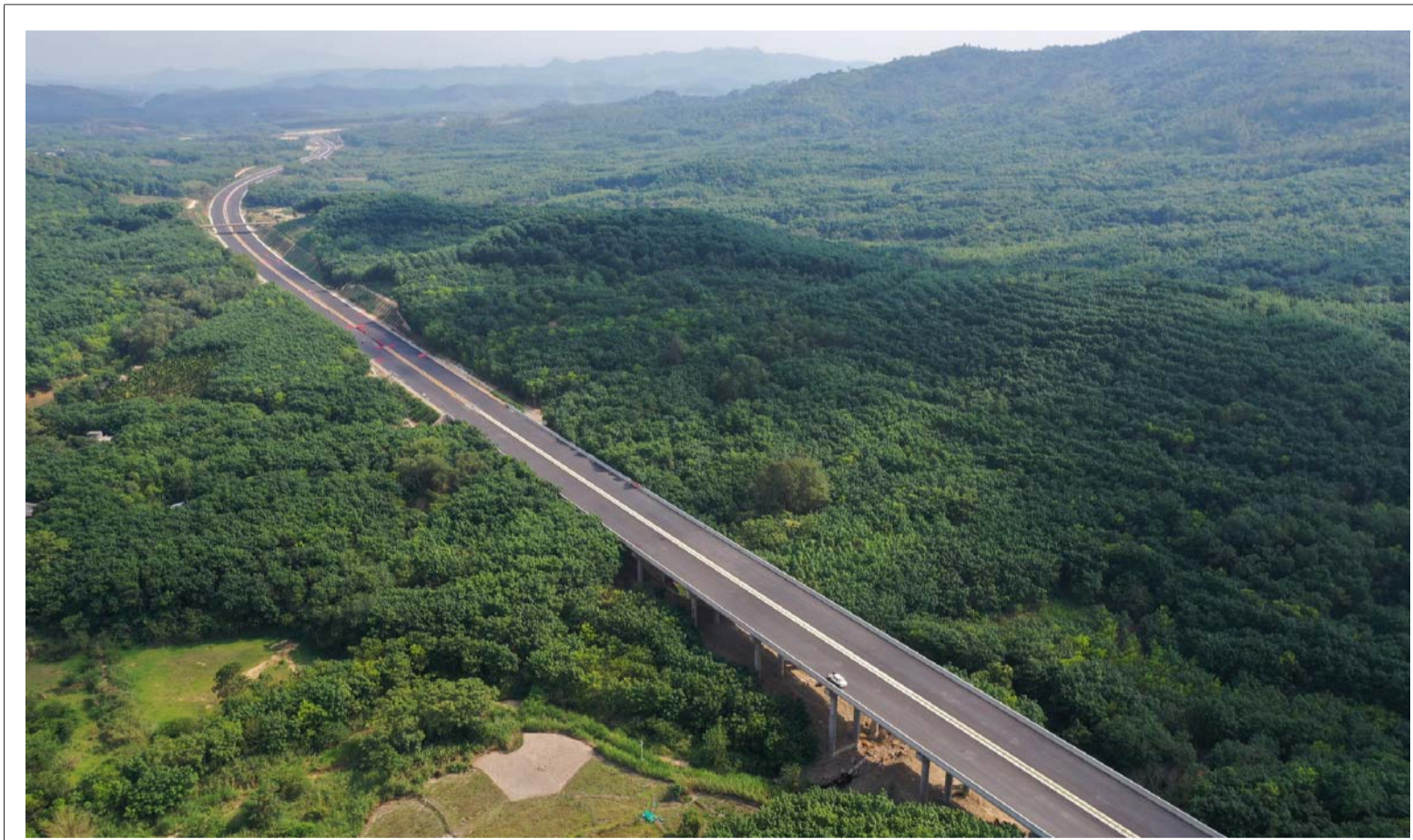
近日,三公司承建的海南万洋高速公路9标那昌大桥全部完工。该桥为全线跨度最大、长度最长的6座大桥之一,全长1747.8米。
