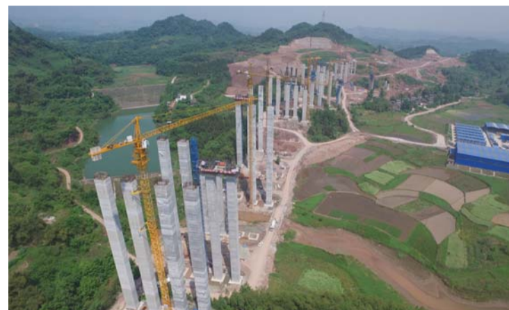
日前，四公司承建的四川省达州市机场大道PPP项目，桥梁下部结构施工全面展开。图为该工程雷家坝大桥高墩柱群。王盛运 摄影报道
