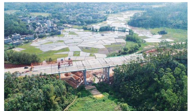
近日,广西玉湛高速公路项目部二工区马兰山大桥箱梁架设顺利完成,开始进入桥面系施工。
