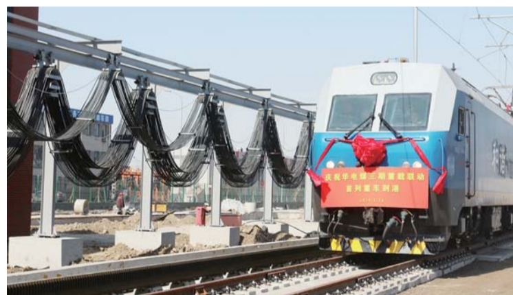
近日,安装公司承建的唐山港曹妃甸港区煤码头三期工程翻堆线重载联动试车成功。 蔡云鹏 刘赵楠 摄影报道
