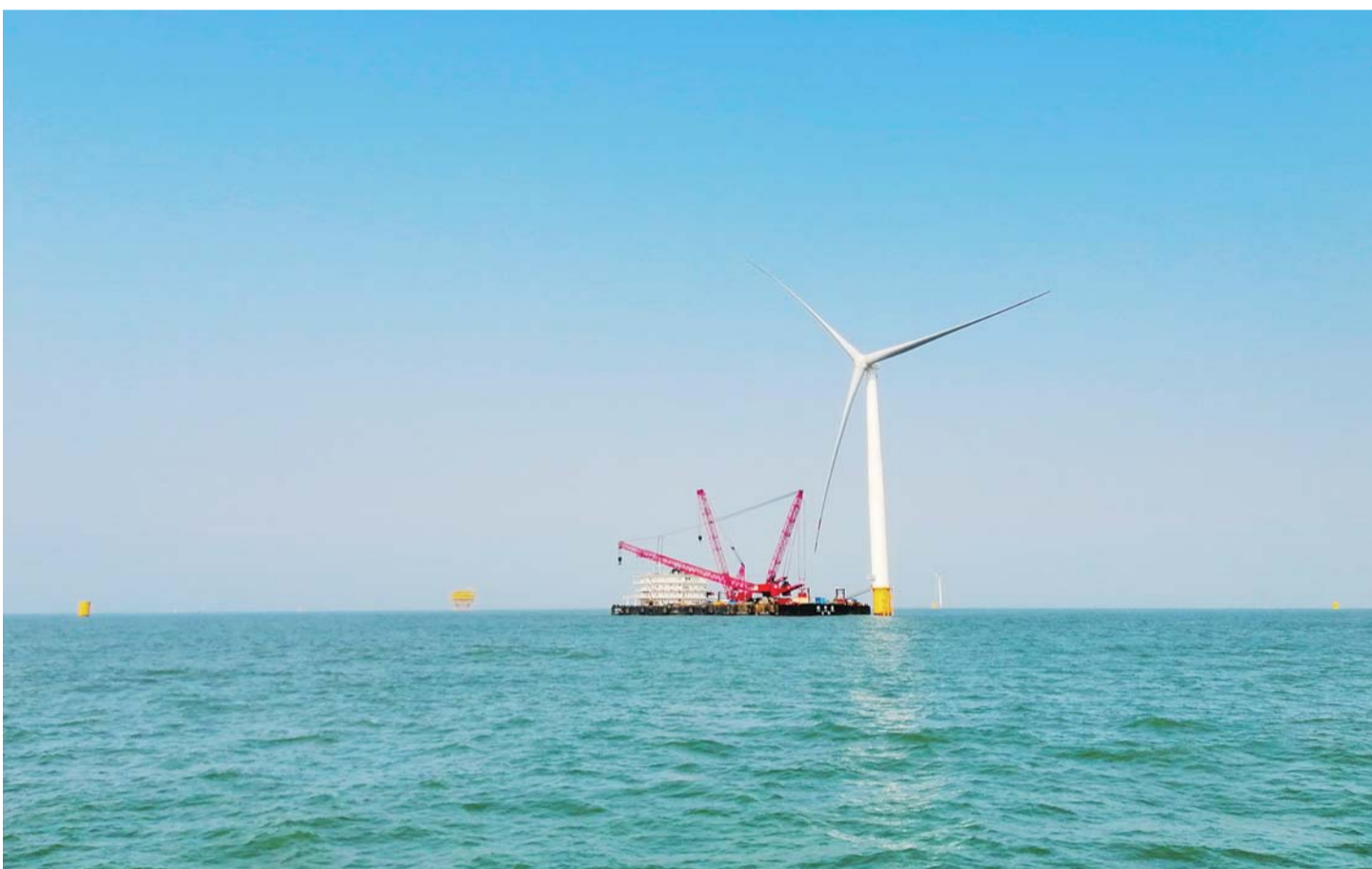
3月22日,总承包分公司承建的广东湛江外罗海上风电项目风机安装工程首台浅水区风机顺利安装完成。 洛成摄影报道
