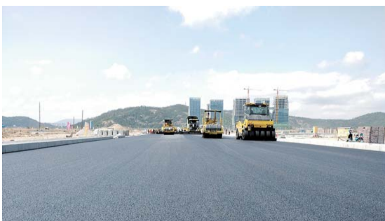
3月22日,五公司承建的珠海市文艺二道横琴大道至香江路段两层沥青全部摊铺完成。 解云青 胡克涛 摄影报道
