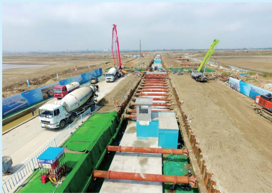
汕头综合管廊试验段主体完工
