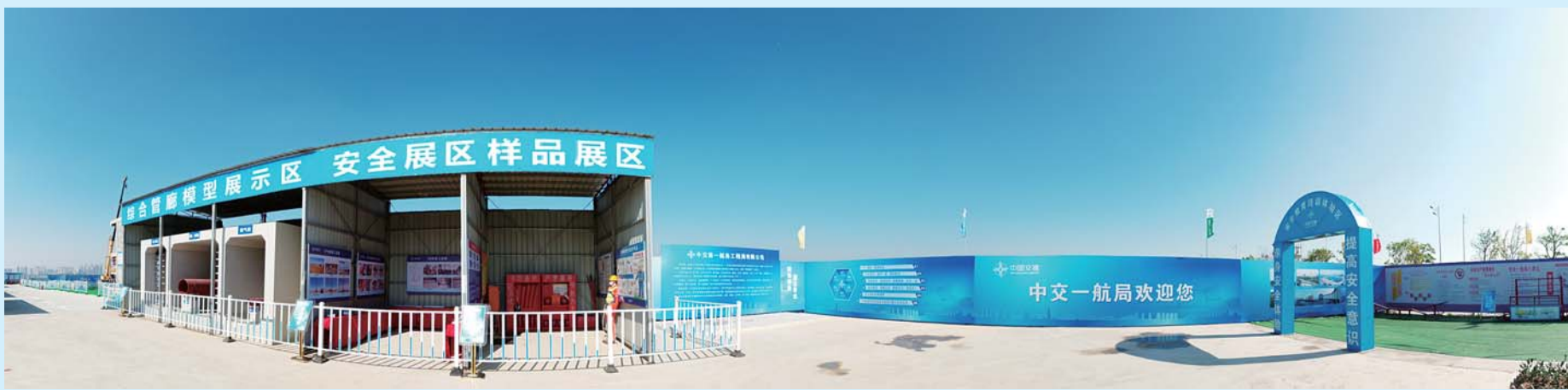
综合管廊展示区全景
