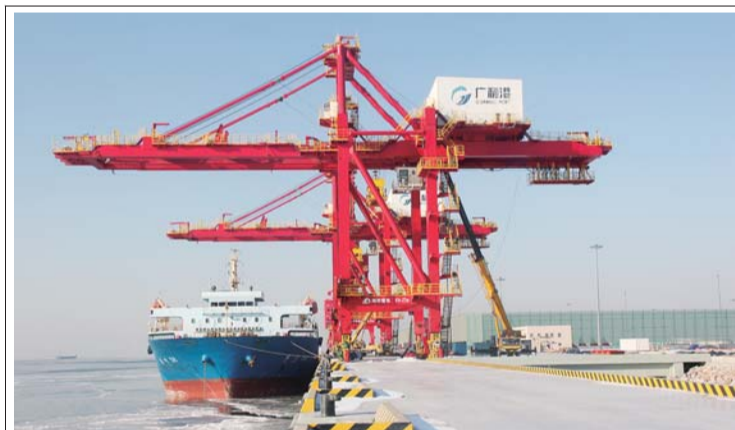
近日,二公司承建的东管港广利港区通用码头一期工程道路、堆场等8个单位工程通过竣工验收。
