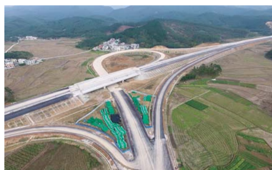
近日，广西贵隆高速公路A04标段完成管段内所有路基及桥面系施工，顺利通过交验。
