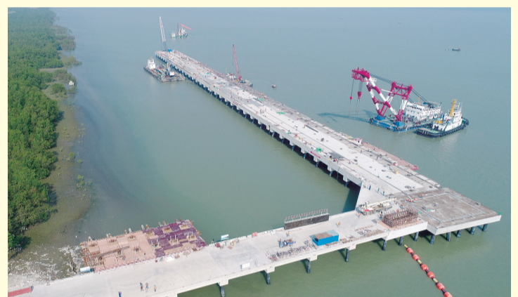
孟加拉帕亚拉燃煤电厂码头及取水工程
