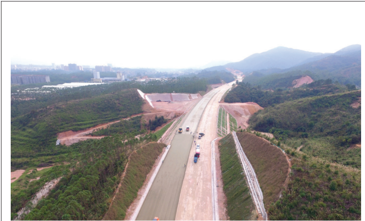
2018年12月21日，广西玉湛高速项目全线首段级配碎石试验段摊铺施工完成。 孙奇 摄影报道
