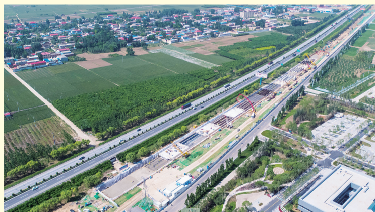
雄安新区容城容东片区截洪渠项目一期工程
