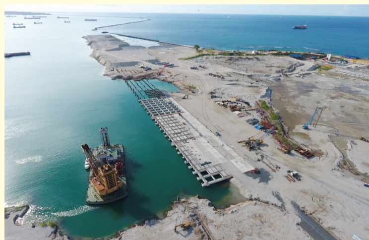
巴拿马 PCCP 码头工程
