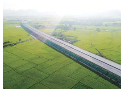
雨后天晴的贵隆高速路面工程 陈曦 摄
