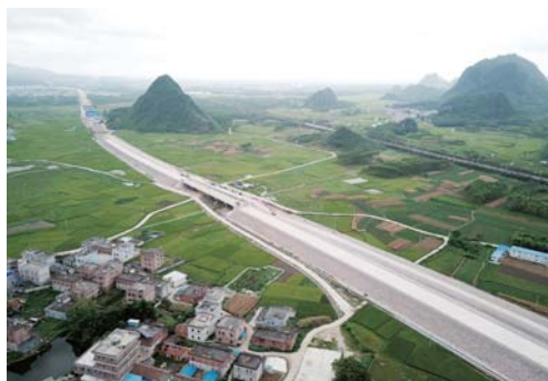
贵隆高速公路路基及桥涵工程 杜建军 摄
