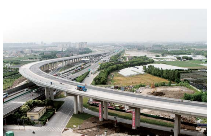
近日,随着最后一根钢箱梁平稳地安装完毕,一公司参建的中国首届进口博览会重要配套项目——上海S26公路入城段新建工程高架主体结构全线贯通。 涂云贵 沈君祥 摄影报道
