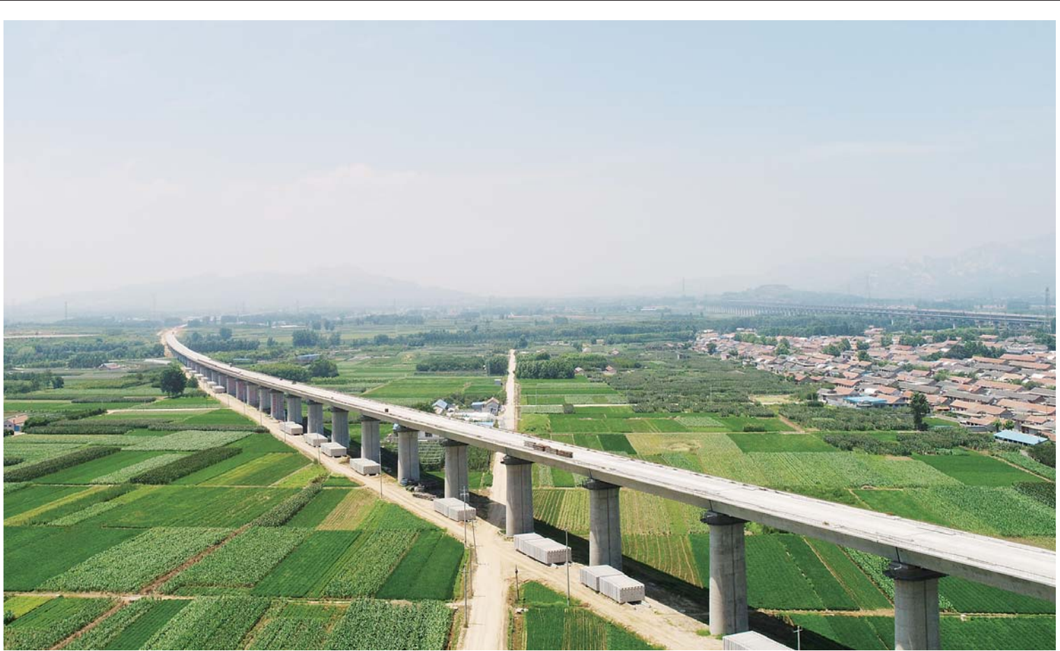
近日,鲁南高铁肖家庄特大桥首架方向20至75号55根箱梁已全部架设完成,提前7天完成业主下达的节点目标。肖家庄特大桥全长2644.2米,跨S222省道连续梁已完成,转体连续梁正在施工。 袁凯锋 摄影报道
