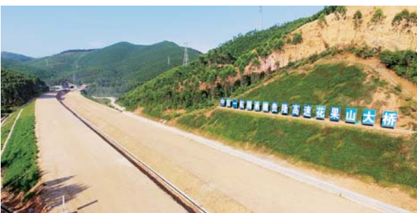
贵隆高速公路路架山大桥及路基 翟超 摄
