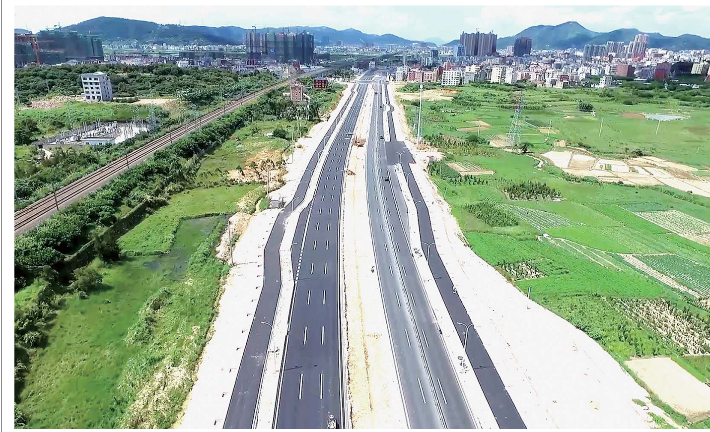
通过竣工验收。该工程2013年10月开工,2017年7月实现全线通车。 王举涛 摄影报道
