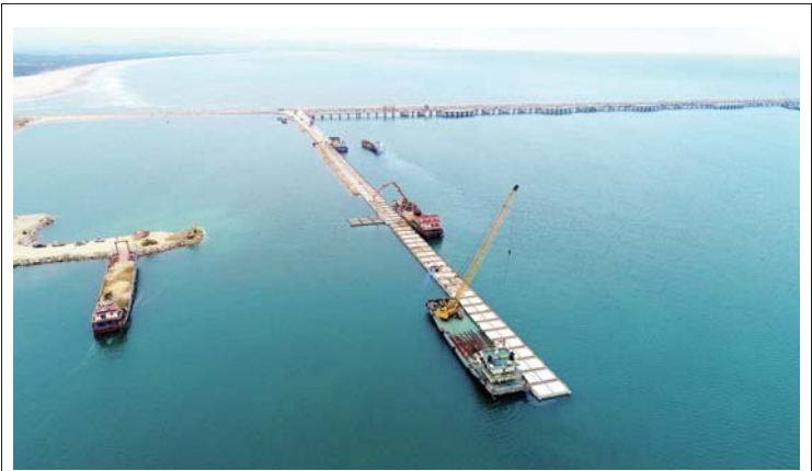
6月1日,五公司承建的中委合资广东石化产品码头工程全部沉箱封仓混凝土浇注施工完成。目前已进入墙墙施工阶段。 强生鑫 李戈 摄影报道
