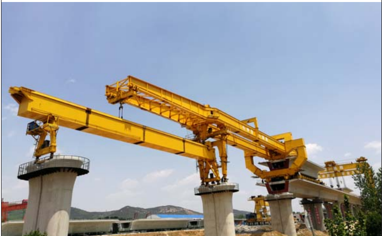
近日,二公司鲁南高铁项目日架8榀900吨简支箱梁,创公司单日架梁新纪录。该项目共需架设箱梁484榀,目前已完成166榀。梁星 曹滢涯 摄影报道
