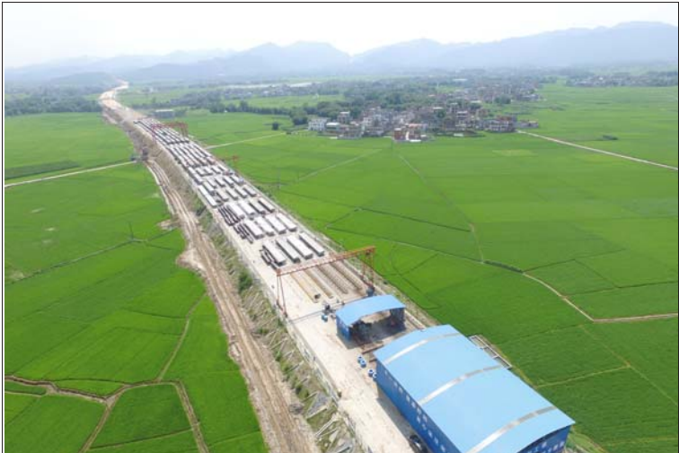
5月16日,五公司承建的贵隆高速公路A01标段预制梁场完成全部箱梁预制。图为预制场全景。薛效雨 邱逸芬 摄影报道
