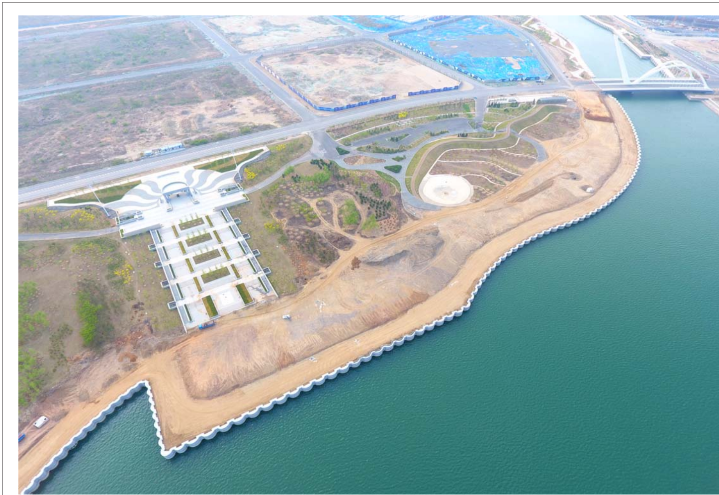
5月15日,三公司第九项目部承建的卧龙湾国际商务中心护岸工程第一标段全部完工。于军 魏冠臣 摄影报道
