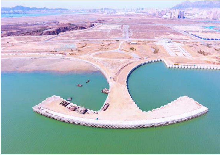
近日，由三公司第九项目部承建的卧龙湾国际商务中心护岸工程（二标段）完成胸墙面层浇筑施工。
