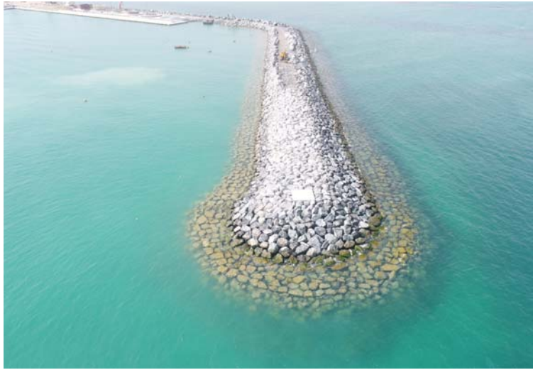
5月8日，三公司迪拜哈翔电厂项目西防波堤主体结构完工。
