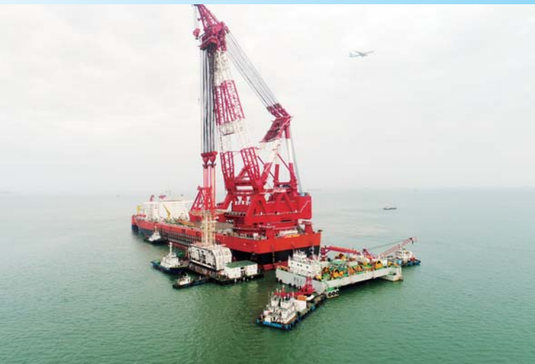
港珠澳大桥岛隧工程最终接头安装成功
