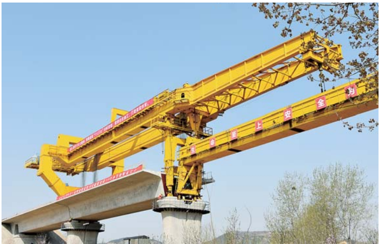
近日，二公司鲁南高铁项目顺利完成首架方向第100根箱梁架设任务。该项目共承建5座高铁简支箱梁特大桥，全长累计15.8公里，需架设箱梁481根，其中首架方向293根。 袁凯锋 曹涯温 摄影报道
