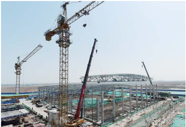
4月16日，四公司承建的天津临港科研试验基地项目水工试验大厅工程大跨度钢桁架吊装全部完成。 周博 王涛 摄影报道
