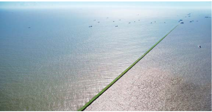
长江口深水航道整治工程
