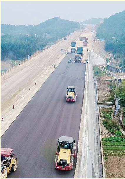
▲贵隆高速公路路面施工
