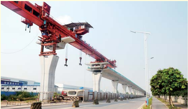
▲佛山地铁 2 号线节段梁架设
