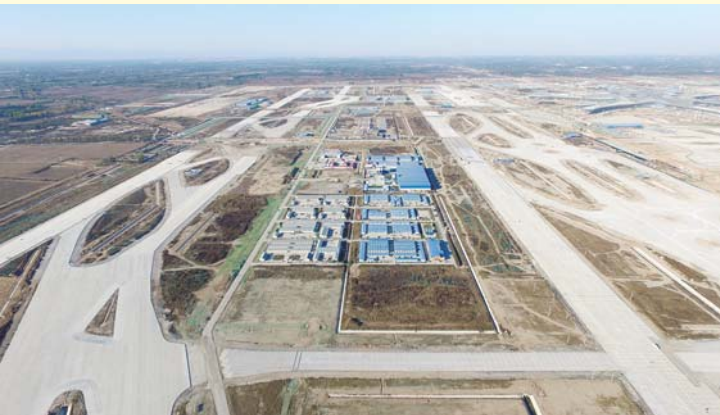
▲北京新机场道面施工
