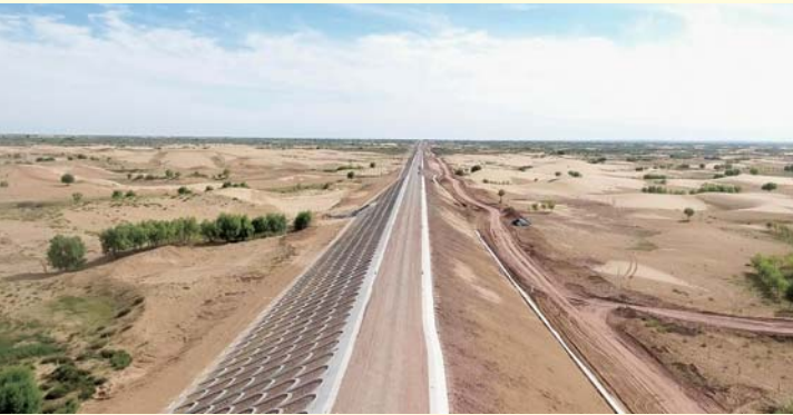
▲蒙华铁路路基施工
