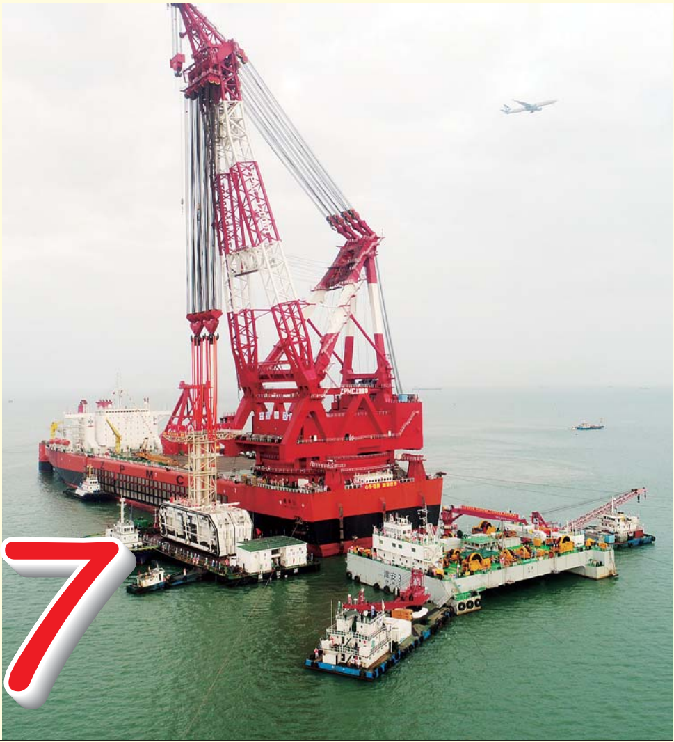
▲港珠澳大桥岛隧工程最终接头安装成功
