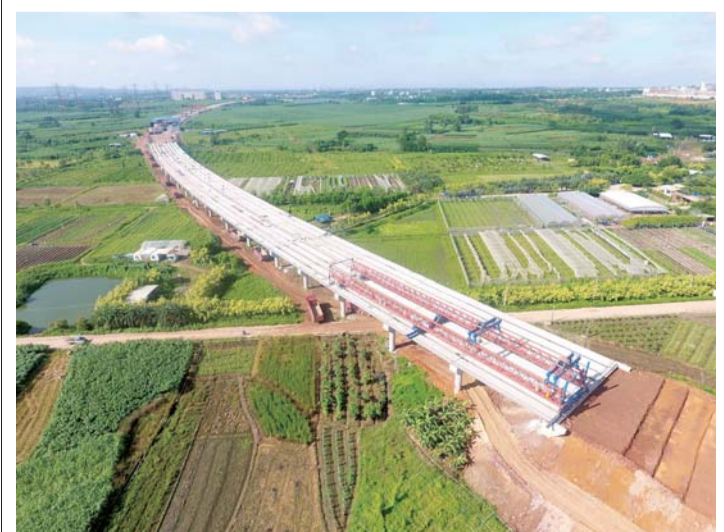
7月4日,广东玉湛高速公路项目乡道130分离箱梁架设全部完成。 杜洪飞 刘召阳 摄影报道
