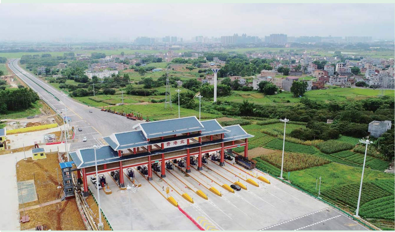
贵隆高速公路贵港北收费站
