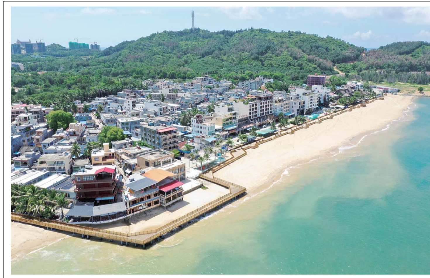
近日,三公司承建的土福湾赤岭渔村岸线修复整治工程正式竣工并投入使用。 李梓维 摄影报道
