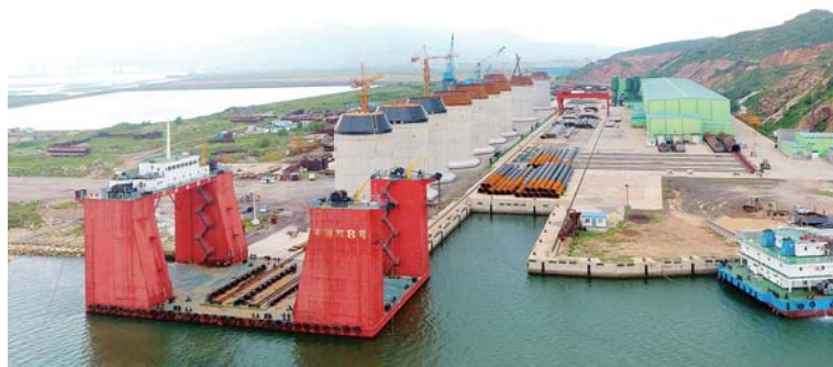
3 月 24 日,三公司第一项目部负责预制的恒力石化长兴岛北岸作业区 110 号泊位 1 号沉箱混凝土浇筑完成。董天杰 摄影报道
