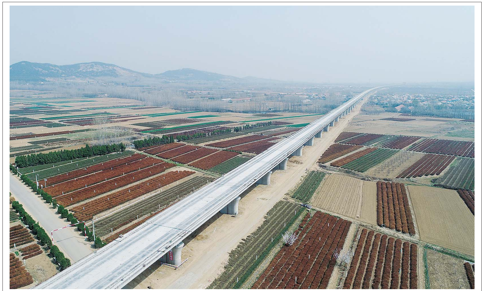
公司承建的粤南高铁高架方向箱梁架设稳步推进。据悉,箱梁架设计共 139 榀,分两个阶段进行。目前,第一阶段箱梁架设计完成 85 榀,完成 98 榀架设任务的近九成。袁凯峰 摄影报道
