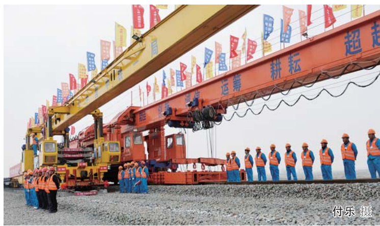
余公里的铺架作业面准备工作,顺利移交铺架作业面达10余公里。蒙华铁路建成后,能够有效提高“北煤南运”铁路通道运输能力,对优化国家能源战略布局,开发蒙
