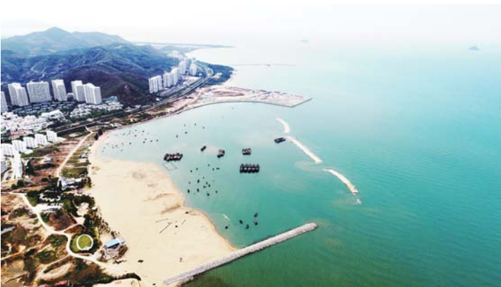
4月22日，由五公司海南项目部负责施工的乐东龙栖湾滩整治暨岸线修复工程项目离岸生态管壳填筑全部完成。
