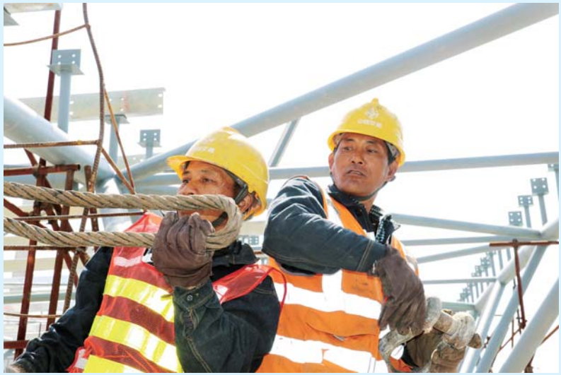
力量的汇聚,架起了工程的脊梁。王海 摄
