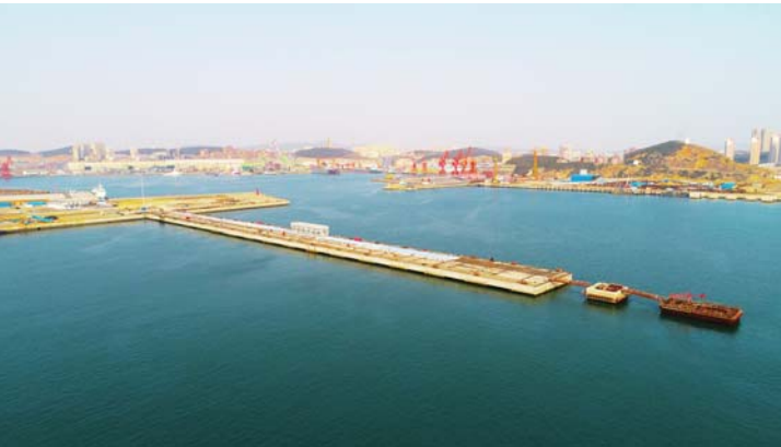
近日，由三公司第十二项目部承建的中远2号船场码头工程完成左幅现浇面层施工2310平方米，占总量的21.4%，为施工机械提供了作业面，为工程保质保量按期完工奠定了基础。
