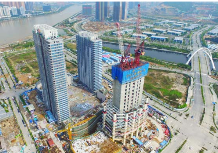
近日，公司承建的中交江通锦琴广场项目3号主塔楼核心筒开始加强层钢结构施工。3号主塔楼楼层高达62层，塔楼高度299.5米。图为20-22层的桁架加强层施工场景。
