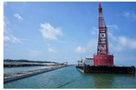
近日，五公司承建的海南省乐东县莺歌海渔港码头沉箱全部安装完成。张宏伟 王朋朋 摄影报道
