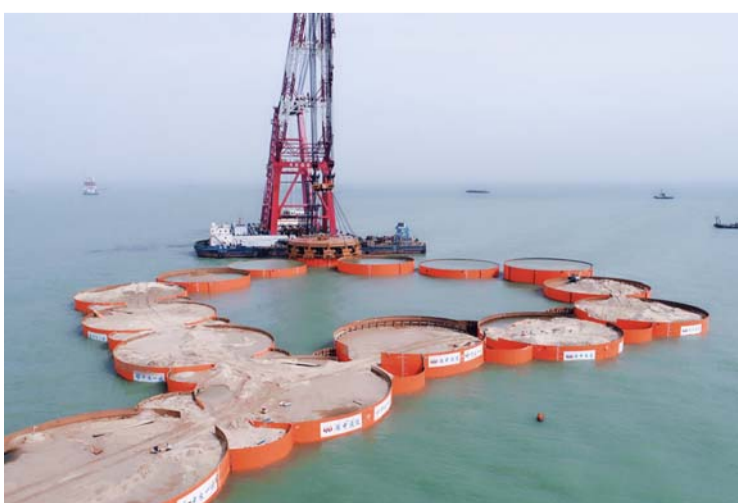
6月2日,随着最后一个钢圆筒顺利沉放,深中通道西人工岛西小岛成功合拢。
