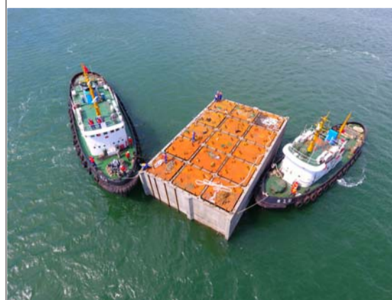
近日,三公司承建的大洋厂1号船坞改造工工程完成首座堵口圈堰沉箱安装施工。
