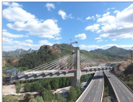
近日,城交公司承建的京沈客专跨承德高速公路大桥矮塔斜拉进展顺利。这是京沈客专河北段唯一一座斜拉桥,也是公司第一座铁路矮塔斜拉桥。
