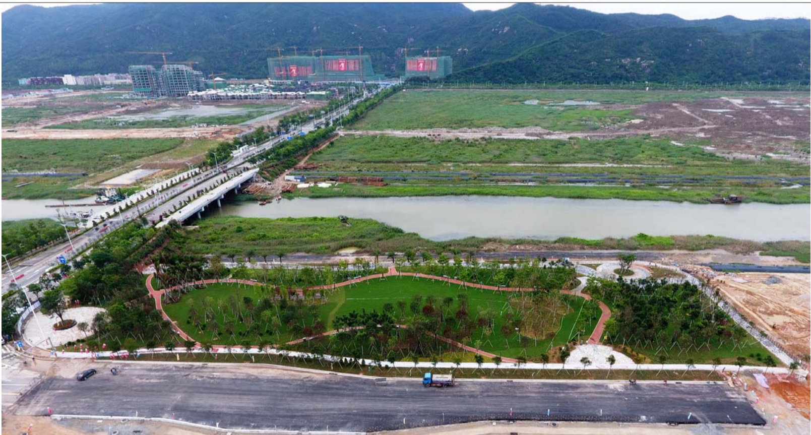
近日,五公司珠海项目部承建的横琴新区天沐河防洪及景观工程样板段完成施工。该景观样板段主题为公园式社区,设计总面积约15.1万平方米。
