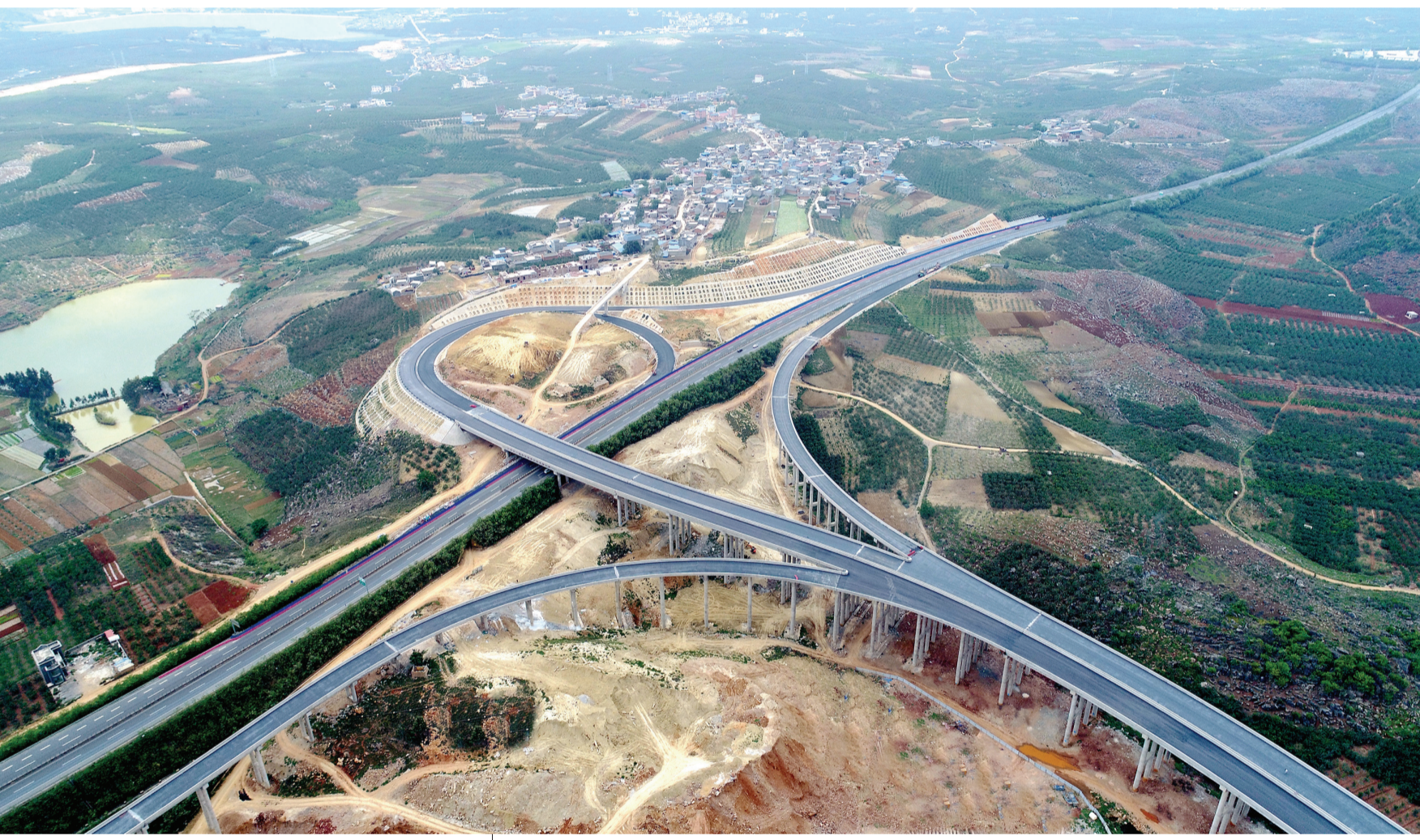
日前,四公司承建的蒙文砚高速公路路面项目进展顺利。该项目路面工程全长32公里,预计6月底全部完工。王乐 杨立志 摄影报道
