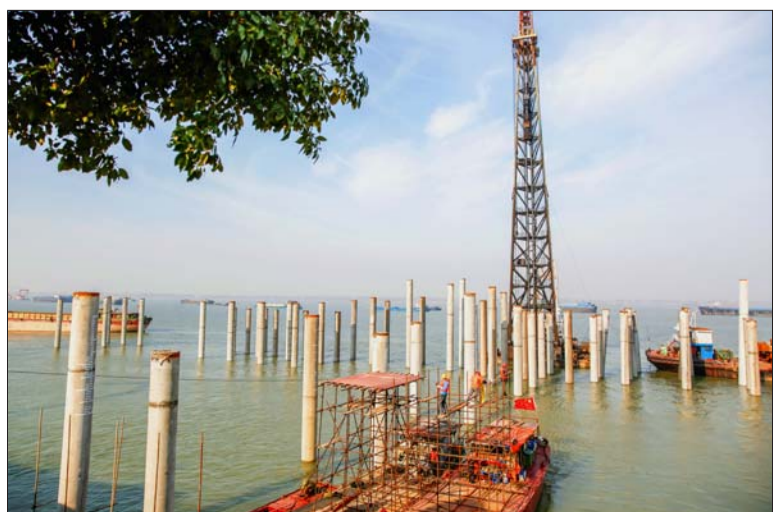
近日，二公司承建的安徽省铜陵市东苑码头改扩建工程沉设PHC桩100根，预制T梁24片，为保证长江汛期前施工节点，满足业主10月份投入使用的要求打下了坚实基础。于鑫 摄影报道
