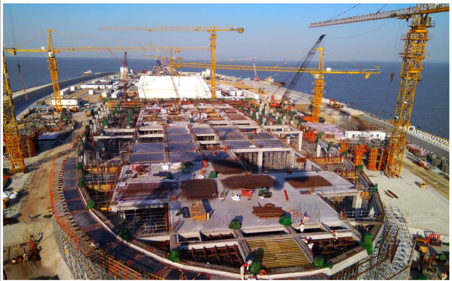
港珠澳大桥岛隧工程西人工岛主体结构施工正在紧张进行中，柱、梁、板钢筋模板安装及混凝土浇筑工作均同步推进。图为施工现场大干场景。董永贺 摄影报道
