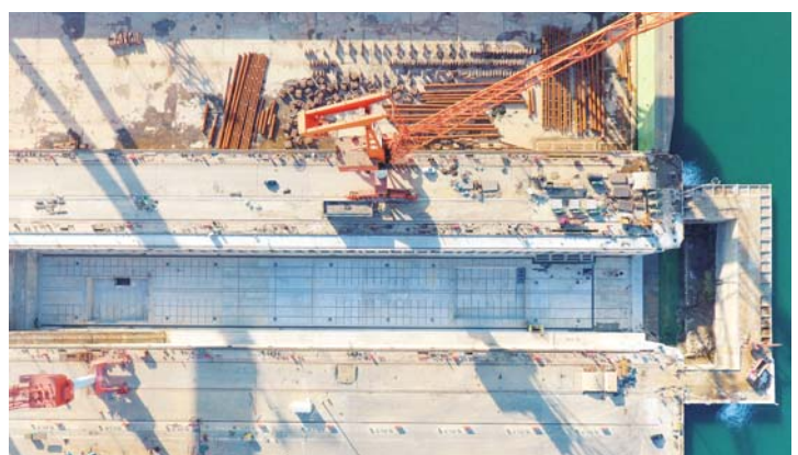
近日,三公司承建的大连船舶重工集团大洋厂区1号船坞改造项目顺利通过预验收。杜邦 摄影报道
