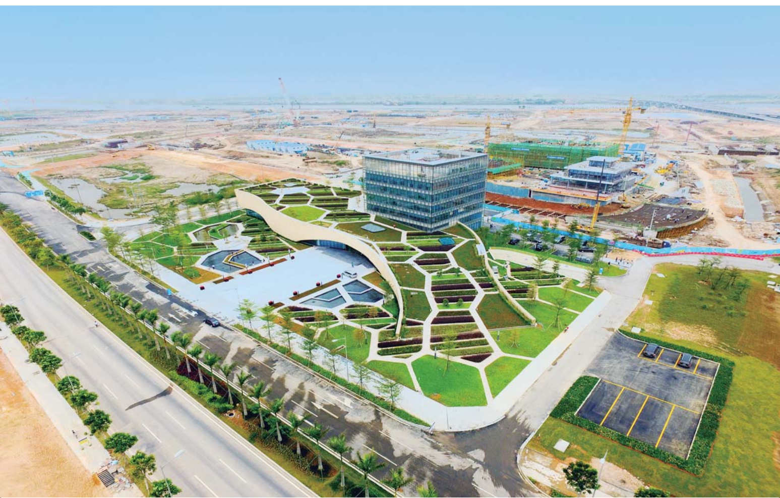
近日,四公司承建的广州南沙明珠湾区展览中心工程全部完工。12月8日,明珠湾展览中心作为广州《财富》全球论坛的“南沙参观日”唯一到访地,吸引了全球多家企业掌门人和多国政要、海内外媒体慕名到访。王洪飞 摄影报道
