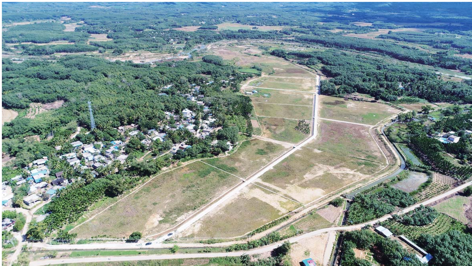
近日,五公司海南项目部承建的乐东县2016年整村推进扶贫田洋高标准农田建设项目进展顺利。该项目属于基础民生工程,是公司首个农田建设项目,施工内容包括土地平整、砖砌渠道和田间路网等建设。王朋朋 谷健 摄影报道
